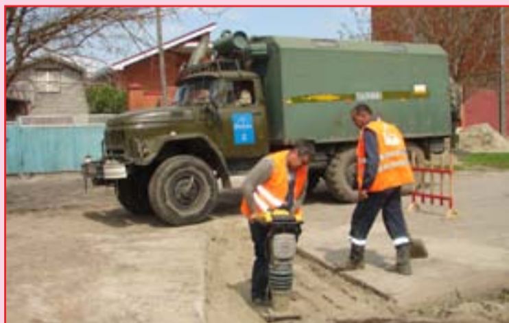
Прокладка канализационного выпуска к дому ветерана П.Н. Колычева
